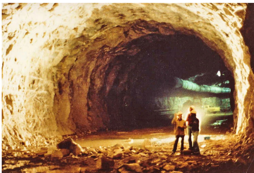
Figura 6 Típico Túnel de Furar e Explodir
